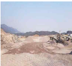
토석채취 공사 현장
